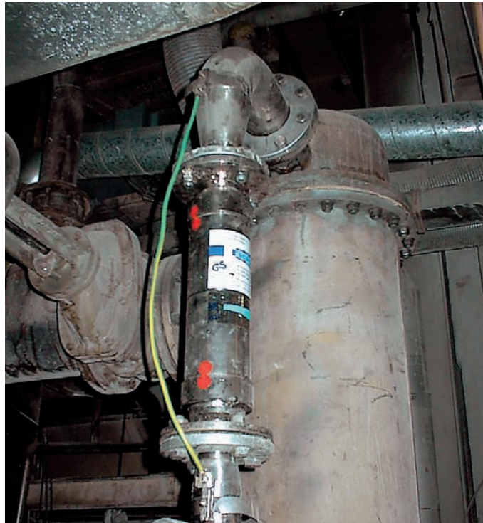
ION-SCALE- BUSTER: schützt den Hilfskondensator
