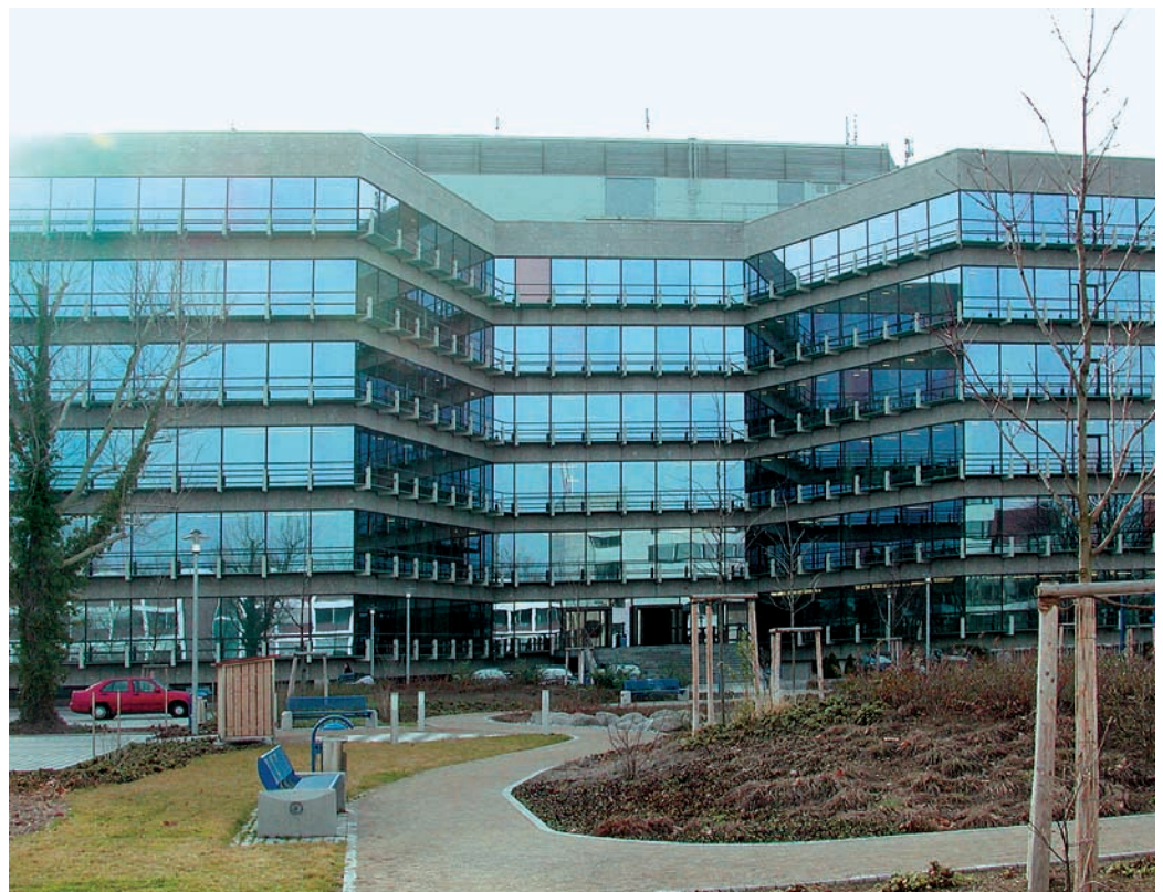
KALKFREIER „WABENBAU“: Das Hauptverwaltungsgebäude der ABB Gebäudetechnik in Mannheim
