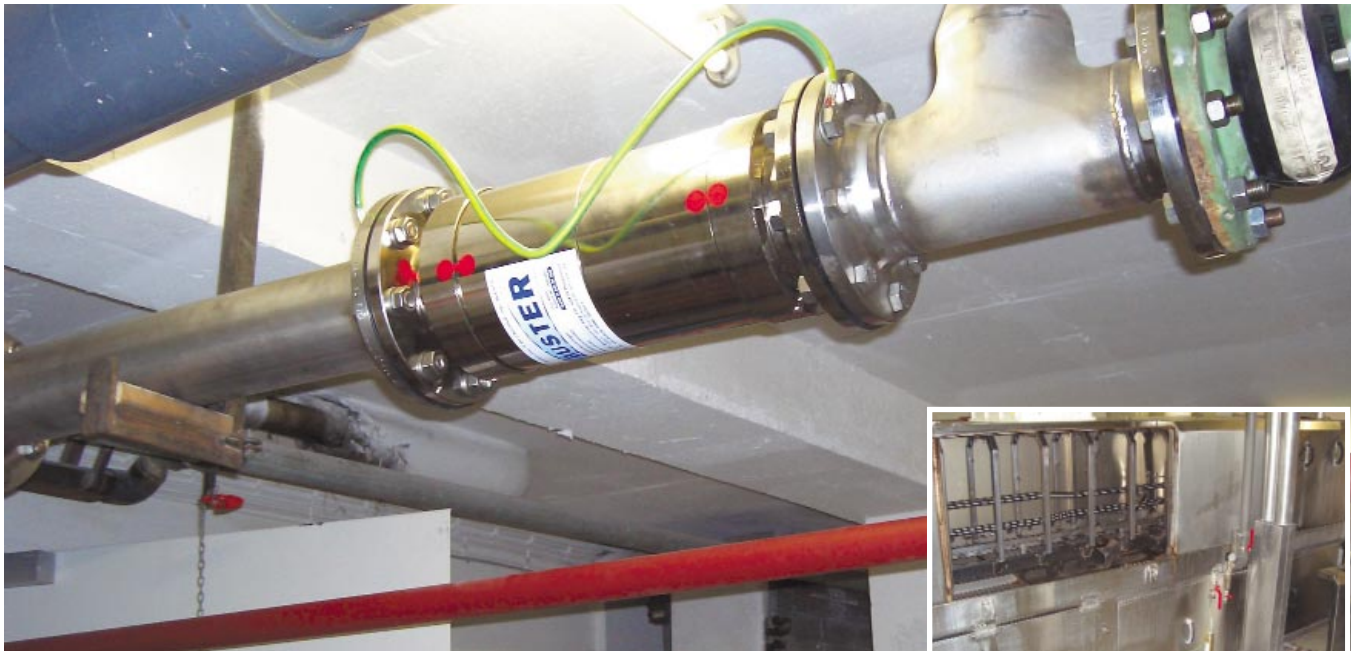
Die Größe des Scale Busters wird in Abhängigkeit von Volumenstrom des Wassers ausgewählt, die Installation erfolgt direkt in die Zuleitung. Fotos: ISB Watertec
